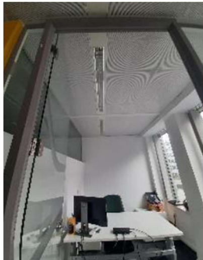
Pas de ventilation dans le local
