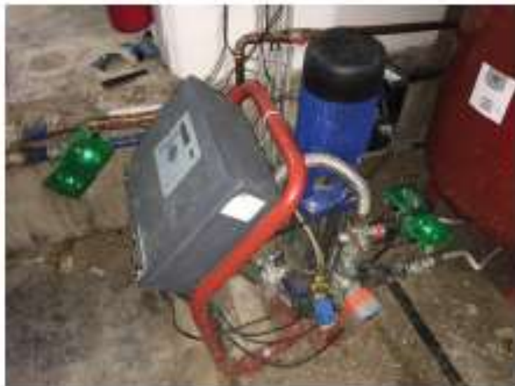
Afb. 12: vier RIsycor CX-en gemonteerd in de installatie
