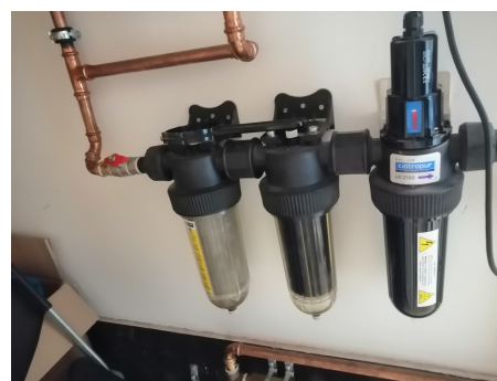
FIGURE 4.3 – Système de purification (Filtre tissé classique, filtre à charbon actif et désinfection UV) de l'eau venant de la citerne d'eau de pluie (Photo de l'auteur)
