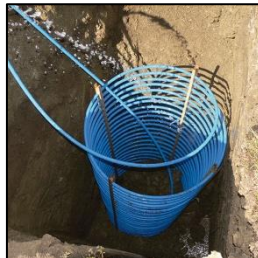
Figure 8 - Corbeille géothermique
