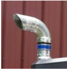
Figure 56 - Sifflet en toiture
