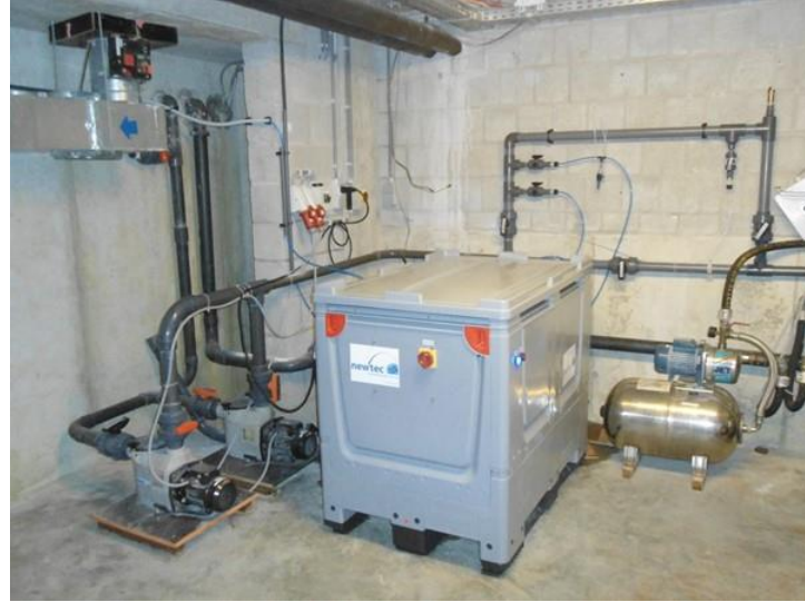
Box met elektrolysecel voorraadvat en regelapparatuur
