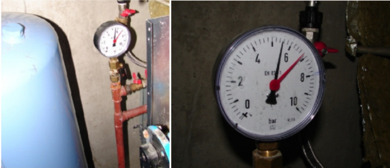
Figuur 5 Vuldruk installatie toren 2
