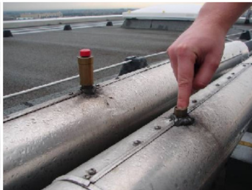
Figuur 8: Vlotterontluchters op het dak van toren 2
