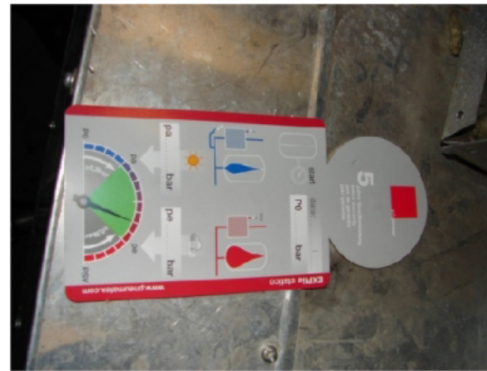
Figuur 4 Label drukinstelling expansievat toren 2
