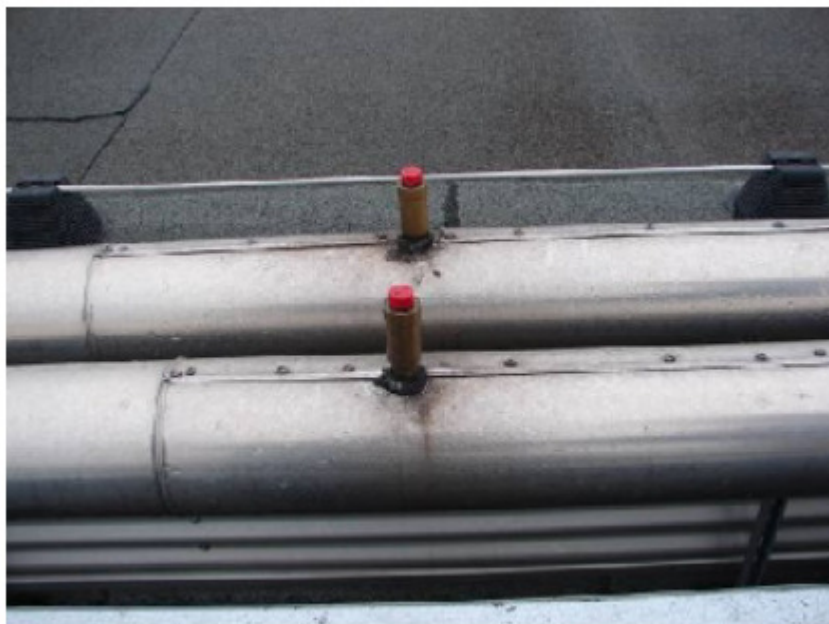
Figuur 8: Vlotterontluchters op het dak van toren 2
